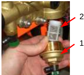
Рис. 81: Грязеулавливающая сетка
