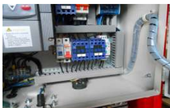
Рис.1. Автомат электродвигателя
