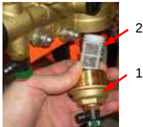
Рис. 81: Грязеулавливающая сетка
